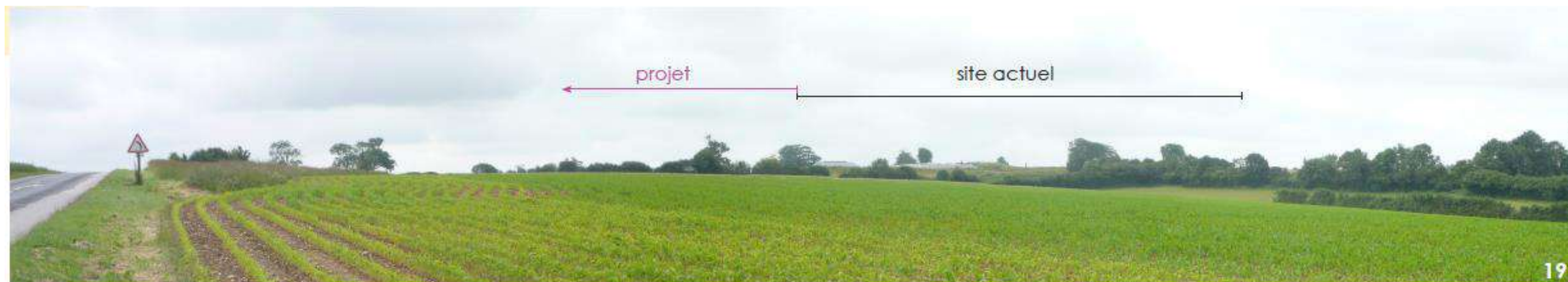
Depuis Hucqueliers, sur la RD343, le site est visible partiellement. Seuls le toit du hangar principal et le casier en cours d'exploitation sont perceptibles. Le reste est masqué par la végétation et la topographie progressive montant vers le site.
