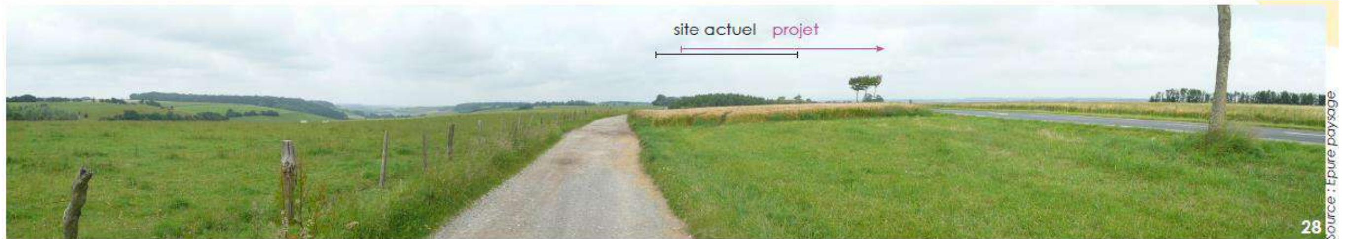
Le chemin d'accès depuis la RD343 offre peu de visibilité du centre de valorisation dans sa version actuelle. Les casiers projetés, plus à l'est et surtout plus au nord sera plus perceptible. Cela reste cependant assez limité.
