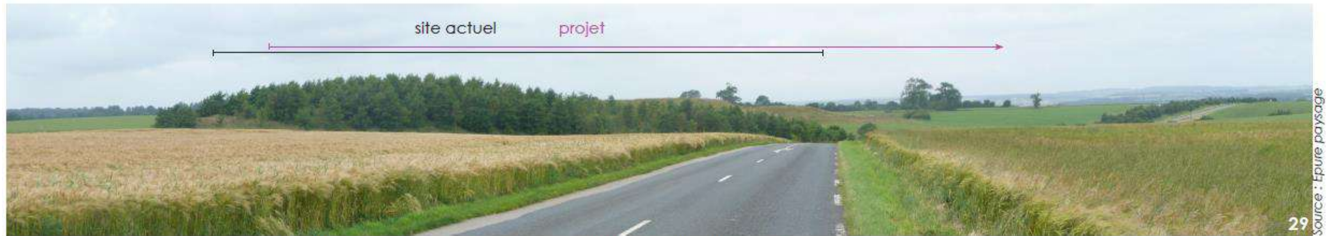
Lorsque l'on s'approche du site par la RD343, la zone projetée est plus visible. La topographie ne permettra pas de proposer des mesures compensatoires efficaces au point de masquer totalement les casiers. Il semble cependant intéressant de créer un accompagnement végétal qui atténuera les effets visuels.
