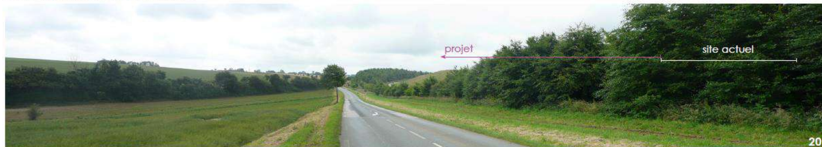
Une fois le point haut atteint, la bordure de la RD343 est accompagnée d'une haie champêtre haute limitant fortement les vues sur le site existant et sur l'extension.
